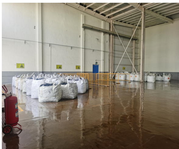
危废仓库的内部标识标牌
