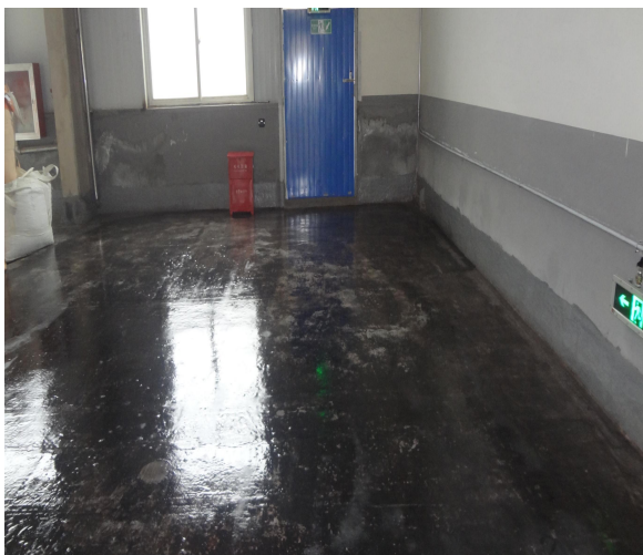
危废仓库地面环氧地坪
